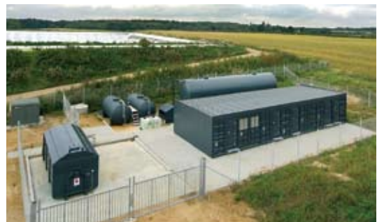
Ein Blick auf die Grundfos BioBooster-Anlage mit bestehender Abwasseraufbereitungsanlage und den Teichen.
