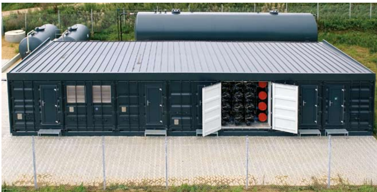
Molkerei Thise's neue, kompakte und umweltfreundliche Abwasseraufbereitungslösung von Grundfos BioBooster, basierend auf einer Kombination aus PBR- und MBR-Technologie.
